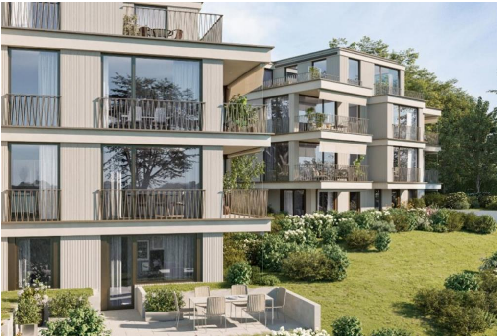
«Kluspark» in Zürich, Architektur: INIZIA AG
