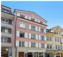
LAUSANNE (VD) Rue de la Mercerie 14-16-18-20
