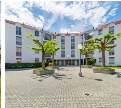
YVERDON-LES-BAINS (VD) Rue des Moulins 36-42
