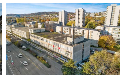
Zurich (ZH), Bernerstrasse Nord 204-210
